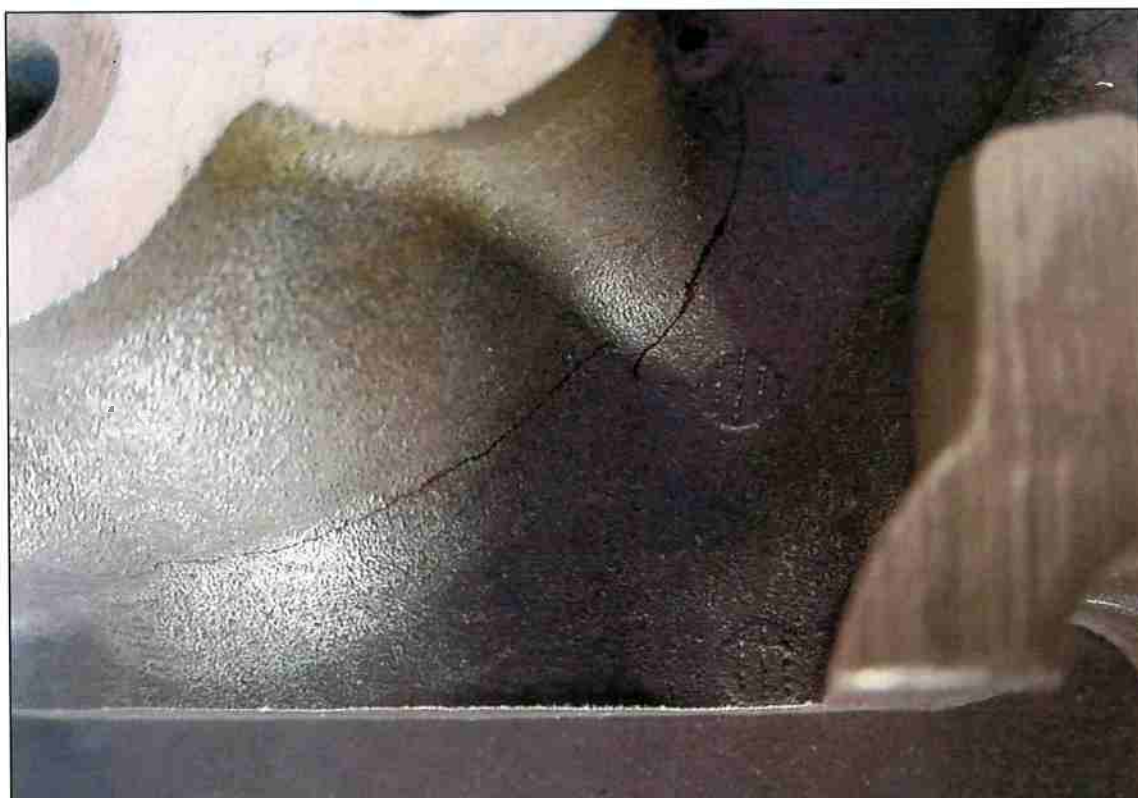
Figura 28 – Trincas provavelmente por fadiga, sendo coincidente com a crítica prevista pela simulação (IPT).
